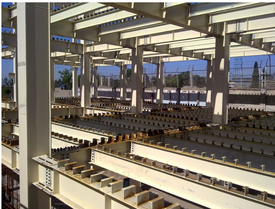
سازه ساختمان تحقیقات و توسعه (شرکت سایپا)
