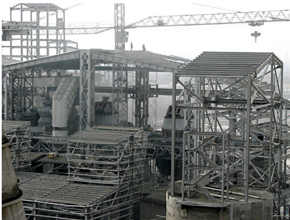
سازه ساختمان آسیاب سیمان (کارخانه سیمان آبیگ)
