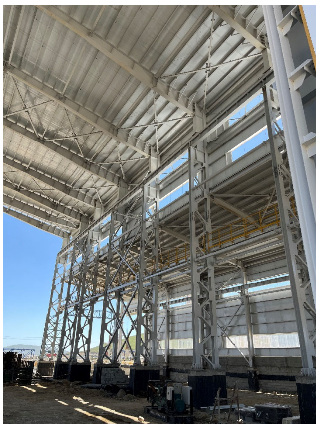
ساختمان کوره آند و BCC , DSB پروژه کاتد مس سونگون
