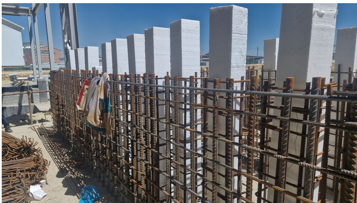
آرماتوربندی فونداسيون كوره آند رفاينگ پروژه كاتد مس سونگون
