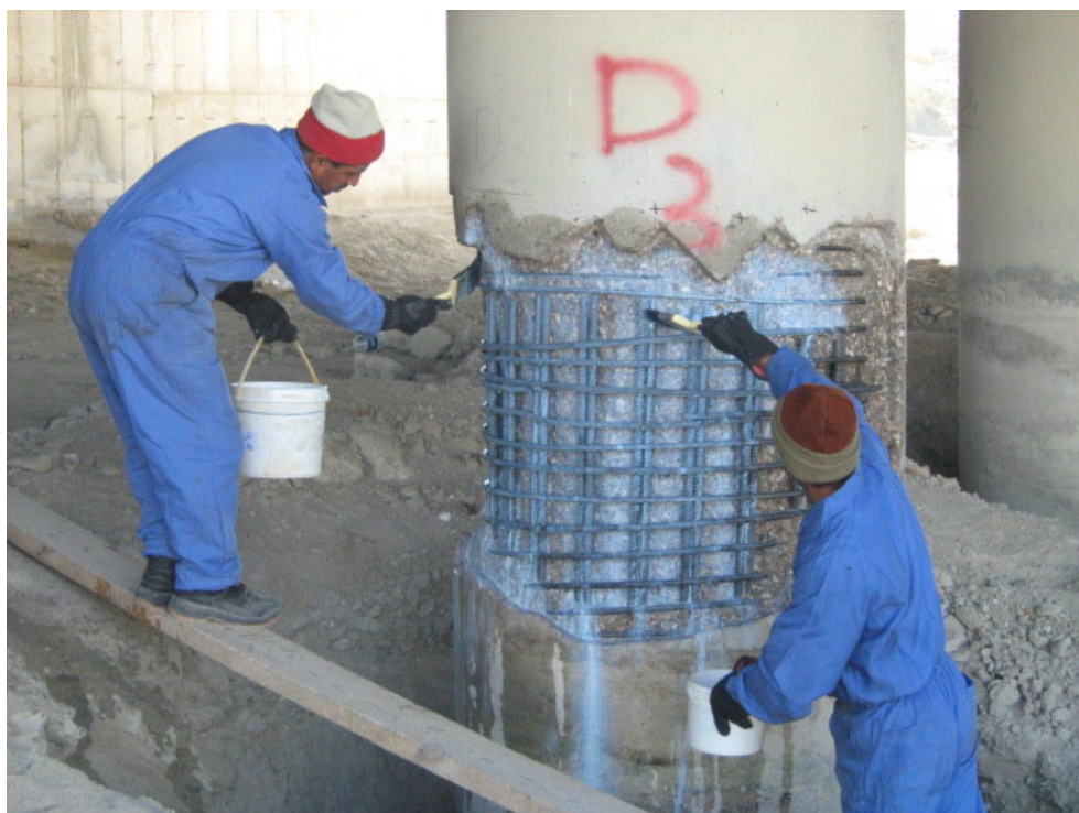
ترمیم و بهسازی پل‌های راه آهن محور زادمحمود-فین واقع در بندرعباس
