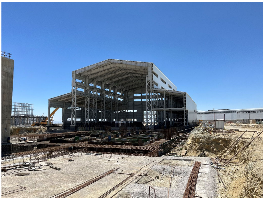
ساختمان کوره آند و BCC , DSB پروژه کاتد مس سونگون
