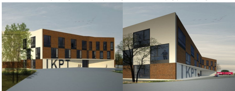
ساختمان اداری کارخانه تولید لوله دقیق کاوه ایرانیان
