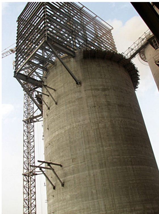
سازه سيلوی هموژن ساز به ظرفيت ۱۲۵۰۰ تن به قطر ۱۶ متر و ارتفاع ۷۹ متر (کارخانه سيمان آبيک)
